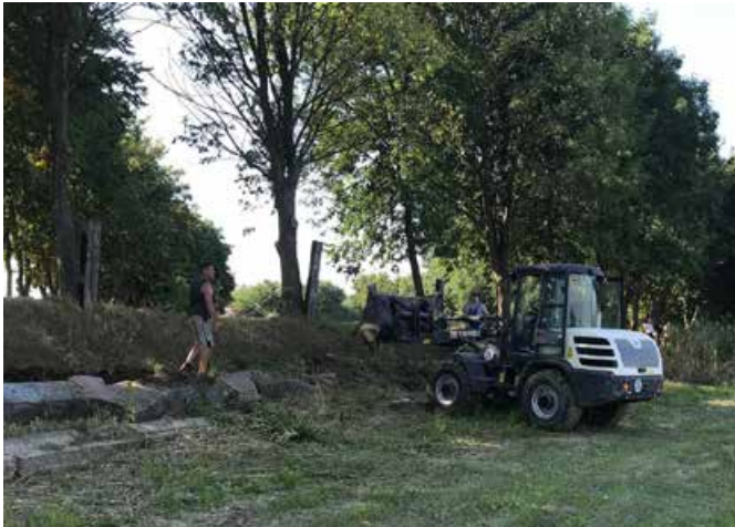
Reparatur Uferbefestigung bei abgesenktem Wasserspiegel
